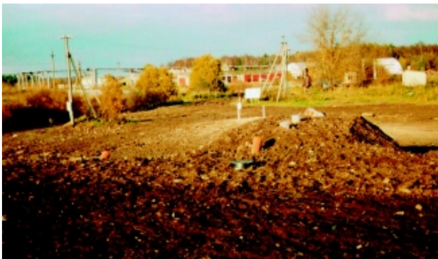
Pinnasekihiga kaetud vajuvoolufilter Kihleveres
